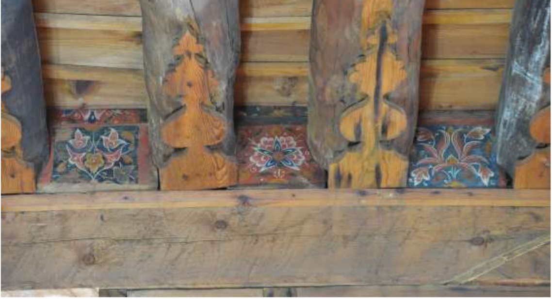
Resim 10: Kiriş Aralarındaki Ahşap Kalemişi Süslemeler
